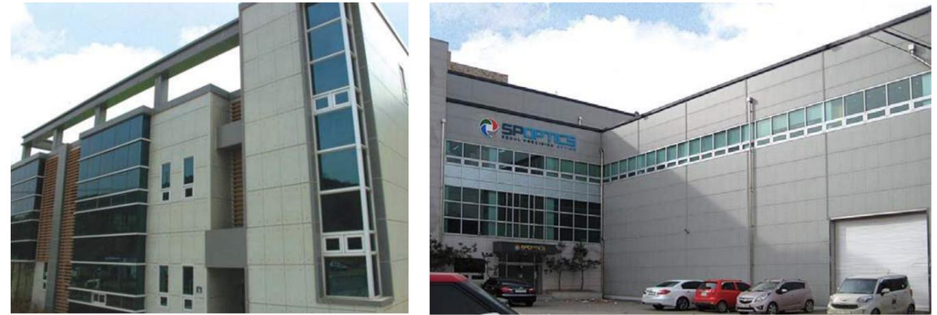
메탈콘판넬 줄눈 간격의 광폭(600 x 1000mm/ 900 x 1000mm 패널 횡방향기준) 노출콘크리트의 자연스러운 질감을 표현한 제품으로 종,횡 시공이 가능합니다.
